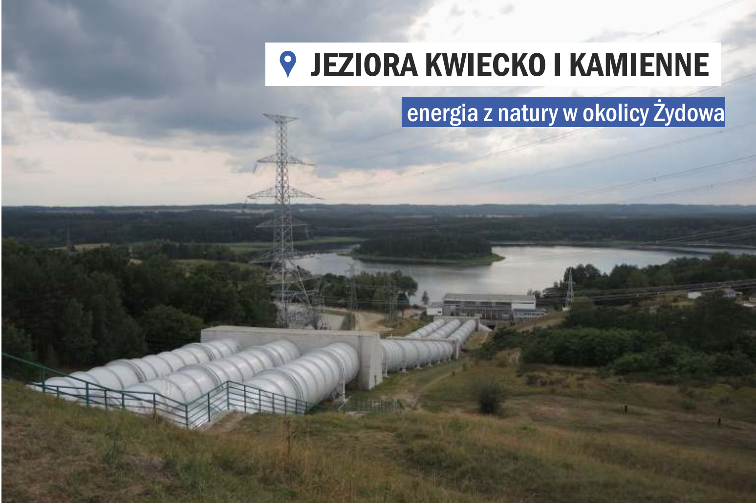
Widok na jezioro Kwiecko oraz system rurociągów, fot. A. Strzelecka
